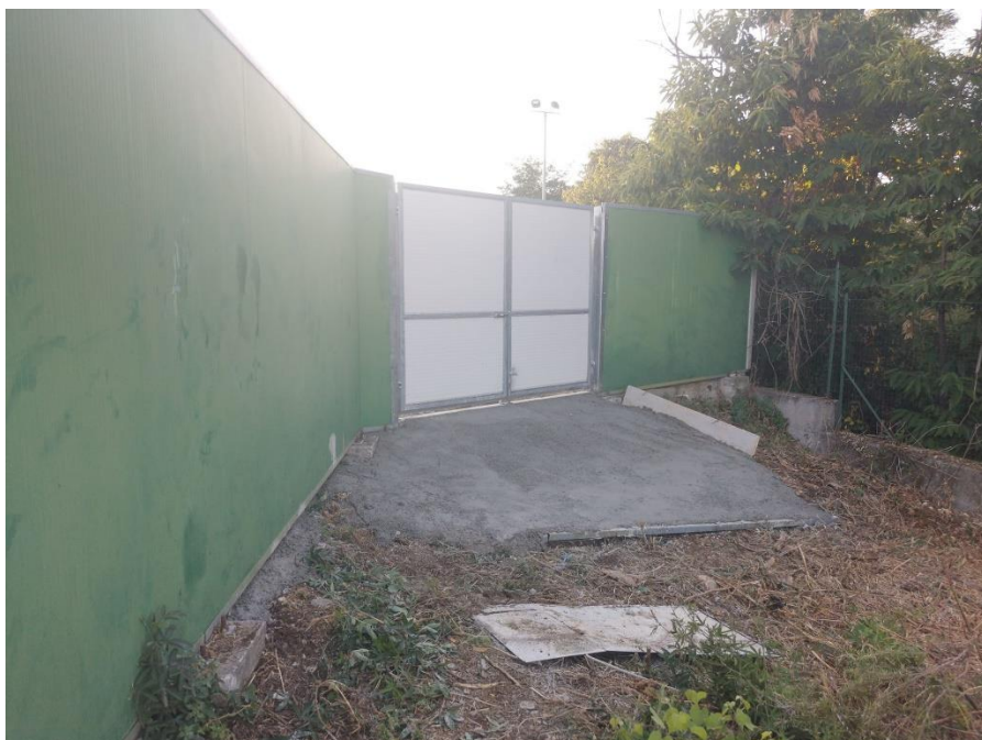
La rampa di discesa di cemento davanti al cancello per l'accesso dei mezzi di lavoro per agevolare la loro entrata nello sgambo.
