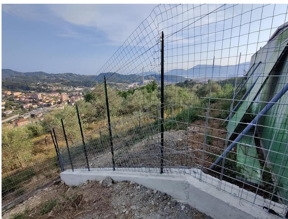
Il muro divisorio per dividere il sesto sgambo da una parte di terreno troppo stretto e scosceso per poterlo utilizzare.
